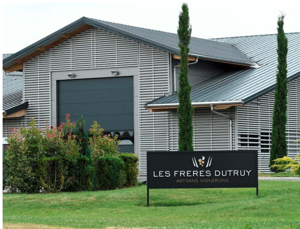
À l'entrée de Founex, les Frères Dutruy ont fait construire de nouveaux chais qu'ils ont inaugurés au printemps 2015.
