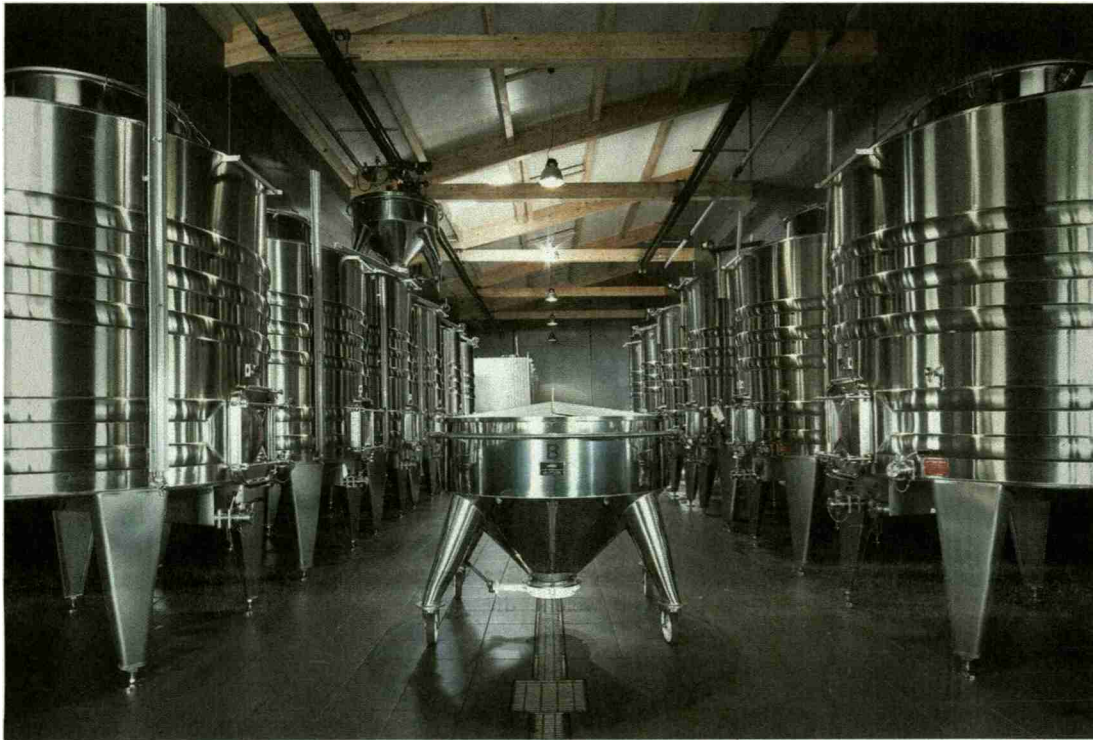
Das neue, aus eigenen Mitteln finanzierte Kellereigebäude (oben) ist mit modernster Technik ausgerüstet. Die trichterförmigen Cuvons (unten) dienen zum Transport der Trauben in die Gärtanks.
